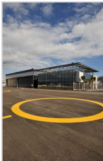
Landeplatz für Helikopter in Cannes (Frankreich), entworfen von Techni Architecture.
